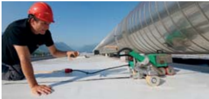
La barra di guida di VARIMAT V2 può essere adattata anche a condizioni di spazio ridotte.
